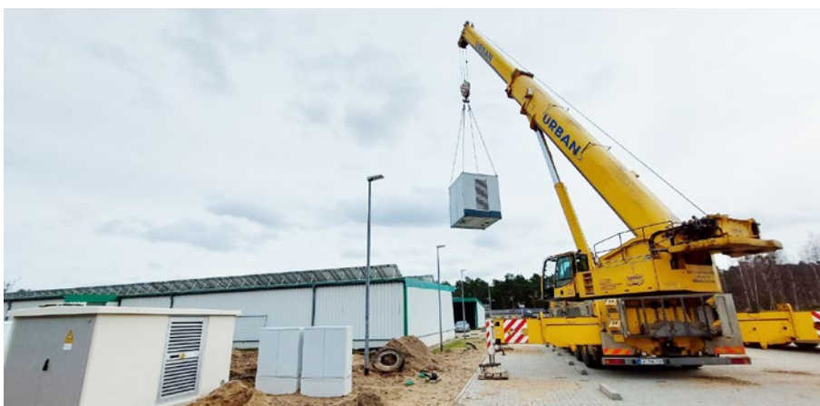
Abb. 4: Aufstellung von Chargern in Ludwigslust.
